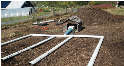
සුළං පංකාව සහ සිදුරු සහිත නළ පද්ධතිය භූමිය මත ස්ථාපනය කර ඇති ආකාරය
